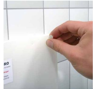
Die hintere Platte wird mit 4 Schrauben und dahinterliegenden Distanzstücken an der Wand befestigt. Die Frontplatte ist mit 4 Flügelmutter aus Kunststoff befestigt.
