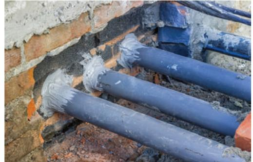
Abb. 15: Abgedichtete Rohrleitungen
